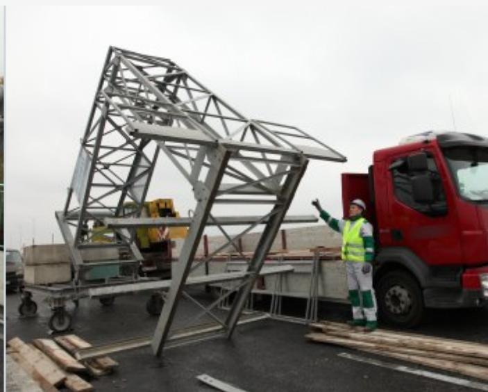
6. Rama podestu przygotowana do montażu desek podłogi
