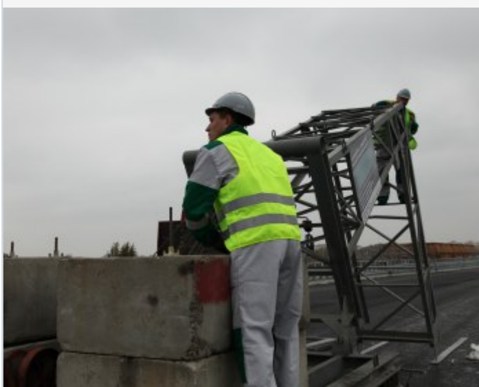
5. Przygotowanie ramy podestu roboczego
