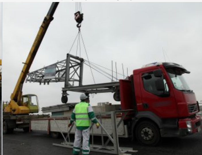
4. Montaż ramienia nośnego do wysięgnika
