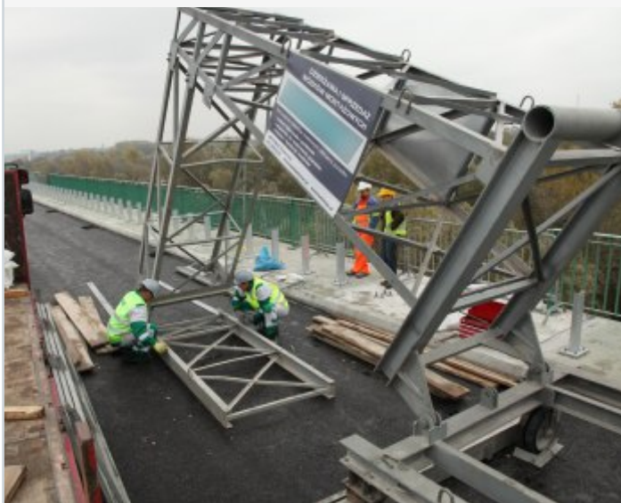
5. Przygotowanie ramy podestu roboczego
