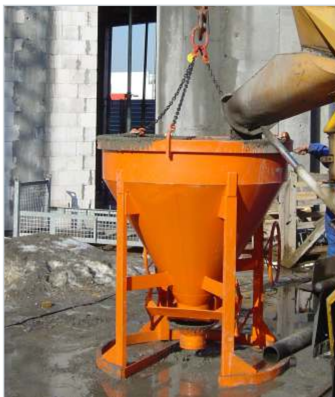
Załadunek mieszanki betonowej do pojemnika na beton typ A.
