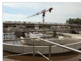
OCZYSZCZALNIA ŚCIEKÓW W TOMASZOWIE MAZOWIECKIM
